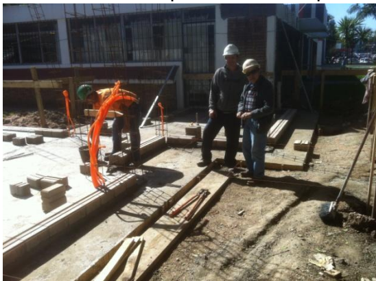
26 abril 2016: colocación de la primera fila de bloques
