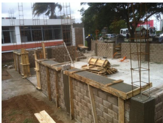
28 abril 2016: antepecho para las tres ventanas posteriores. Encofrados de las columnas del primer tramo de bloques
