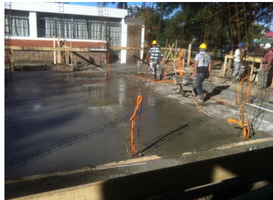
Completamiento piso aula y andenes: 21 abril 2016
