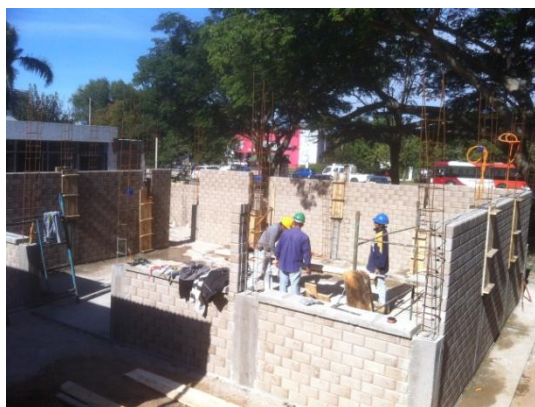
4.5.16 – Alistando encofrado para demás columnas, bigas y antepechos ventanas baños y bebedero
