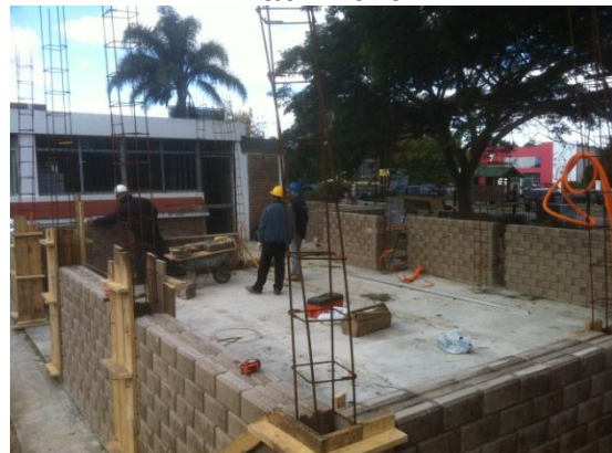
28.4.2016: Primer nivel (9 filas) de bloques colocado
