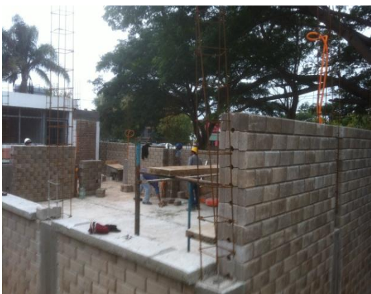
2.5.2016: las paredes progresan al nivel de donde se colocará la biga
