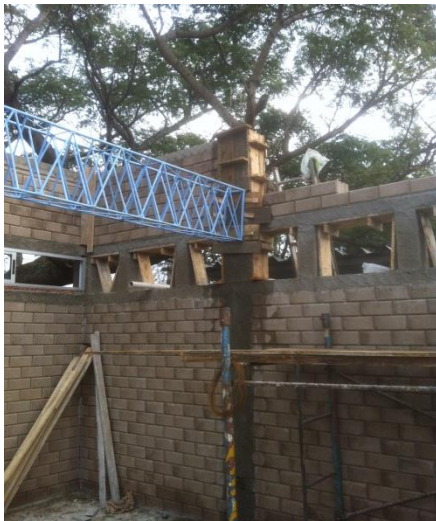
2 de junio: la biga colocada y las paredes laterales se ponen a nivel x el techo
