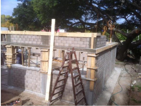
A los 40 días del inicio de la obra así lucía la construcción – 11.5.16
