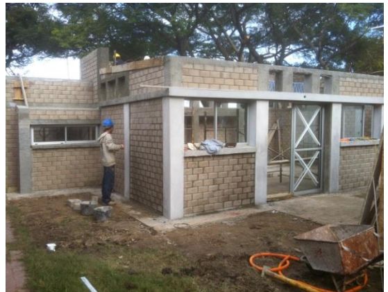
3.6.2016: Ventanas y puerta colocadas; trabajando en mochetas para bigas y columnas. Dos meses y dos días después del inicio de la obra
