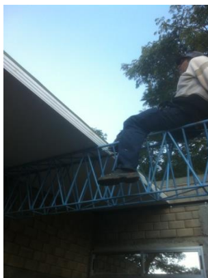
Han pasado escasas 9 semanas, y ya se están colocando los iso-paneles sobre el aula
