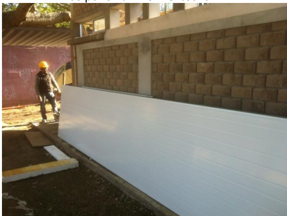
6 de junio 2016: Llegaron los isopaneles para el techo. Son de 6,85 m. de largo y 1,14 m. de ancho
