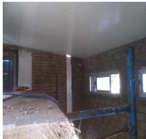
6 de junio 2016 El techo del baño colocado
