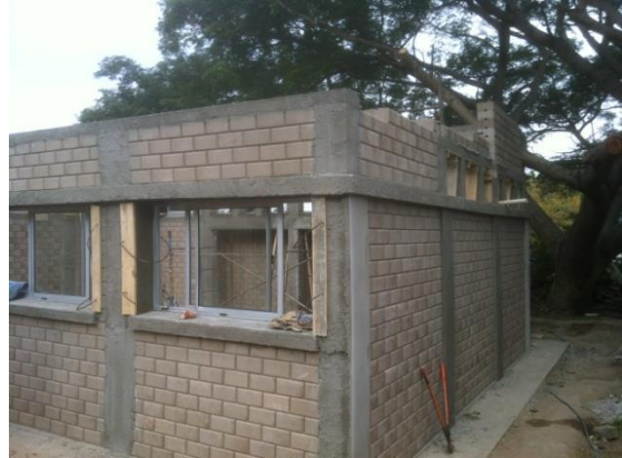
25.5.16 – Las paredes ya están en el nivel requerido para colocar el techo
